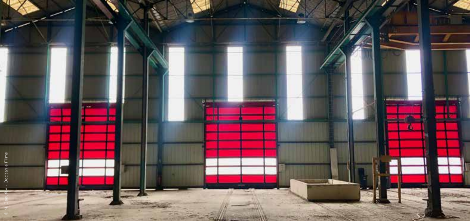
Hangar des colonnes, Hélios, Fabrègues
